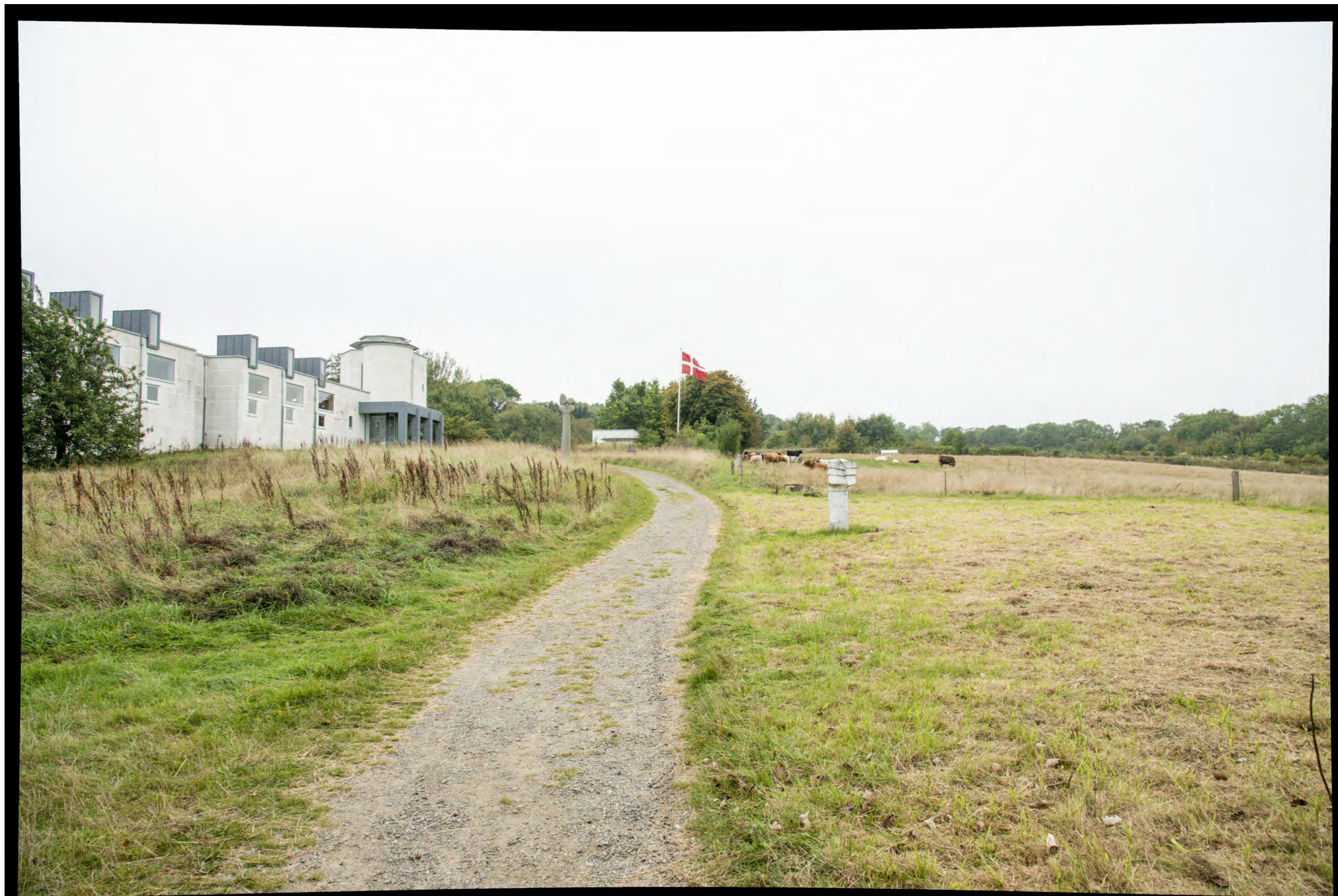
FOTOSTANDPUNKT 06 - STIEN VESTLIGE SIDE SET MOD SV EKSISTERENDE FORHOLD
