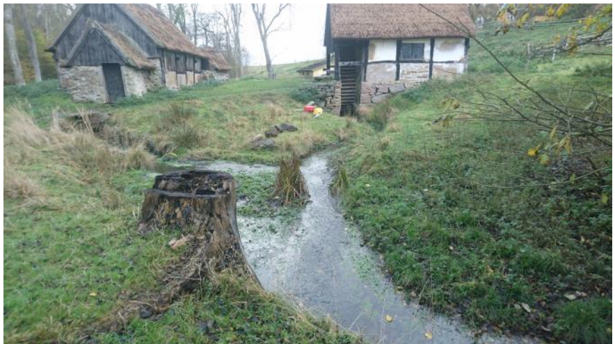
Figur 3.4: Sammenløb mellem afløb fra ørredhus (venstre side af foto) og møllen (højre side af foto). Der løb skønsmæssigt 10 l/s i løbet ved besigtigelsen. Foto: NIRAS 2017-11-15
