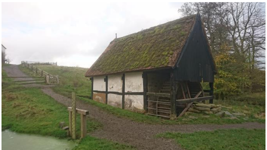
Figur 3.5: Afløbet (slusen) til møllen ses i nederste venstre del af fotoet. Oversiden af sluse (overløb) blev indmålt til kote 2,83. Bund af sluse indmålt til kote 0,83. Møllehjulet ses på den gavl der vender hen mod kameraet. Møllen er af underløbstypen. Foto: NIRAS 2017-11-15
