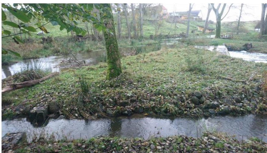
Figur 3.25: Slusegård Vandmølle set mod syd fra starten af omløbsstryget. Omløbsstryget ses i fotoets forgrund. Indtaget til omløbet styres af en støbt betoncant i kote 2,44. Hovedløbet af Øle Å ind i mølledammen ses i fotoets venstre side. Overløbet ses i fotoets højre side. Møllen ses i fotoets øverste højre hjørne. Foto: NIRAS 2017-11-15
