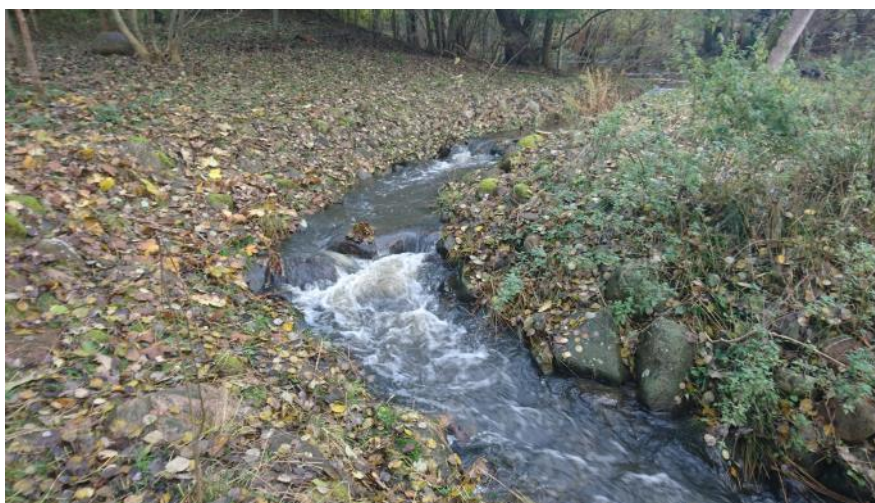
Figur 3.24: Det nuværende omløbsstryg er ca. 23 meter langt og afvikler ca. 1 meter fald, svarende til ca. 45 %. Faldet er dog ikke jævnt fordelt og den nederste halvdel afvikles med over 60 %. Bundbredden er ganske begrænset, ca. 20-50 cm. Omløbsstryget er udtørret om sommeren. Foto: NIRAS 2017-11-15
