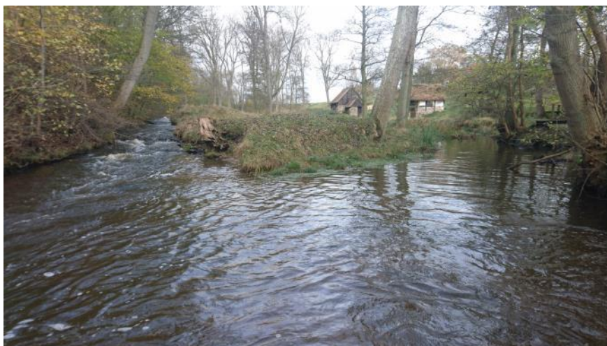
Figur 3.14: Overløbet ses til venstre i fotoet. Friløbet ses i højre side. Ved sammenløbet er der skabt et dybt høl grundet den meget høje vandhastighed i omløbet. Foto: NIRAS 2017-11-15
