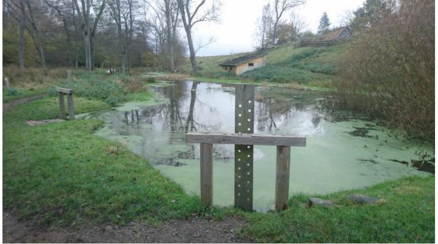
Figur 3.8: Mølledammen set opstrøms fra slusen til møllen. Klækkehuset samt kildehuset ses bagerst midtfor til højre. Foto: NIRAS 2017-11-15
