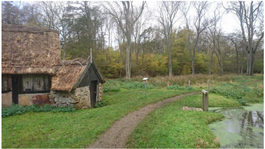
Figur 3.6: Afløbet (slusen) til ørredhuset ses i fotoets nederste højre hjørne. Oversiden af sluse (overløb) blev indmålt til kote 2,82. Bund af sluse indmålt til kote 1,25. Ørredhuset har tidligere været anvendt til fangst af havørred til strygning og klækning til kompenserende udsætninger. Ørrederne blev lokket ind i "gården" i huset ved at lede den primære vandstrøm gennem huset i den periode hvor fiskene søger opstrøms. Foto: NIRAS 2017-11-15
