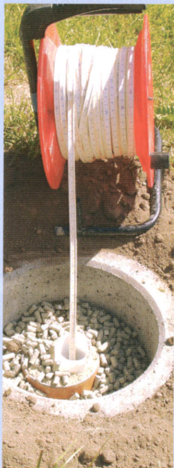
Overvågningsboring hvor der pejles.
